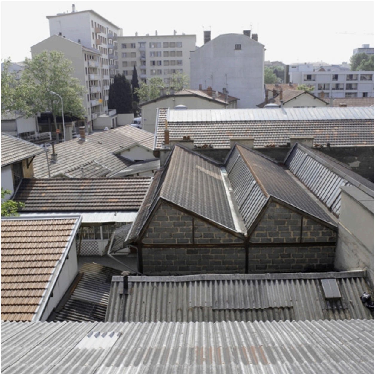
Vue nord-ouest des ateliers
