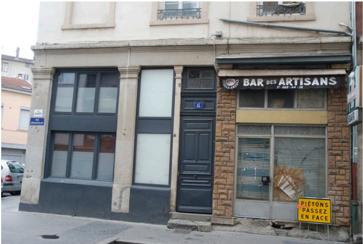
Elévation sur la rue Béchevelin, vue du rez-de-chaussée
