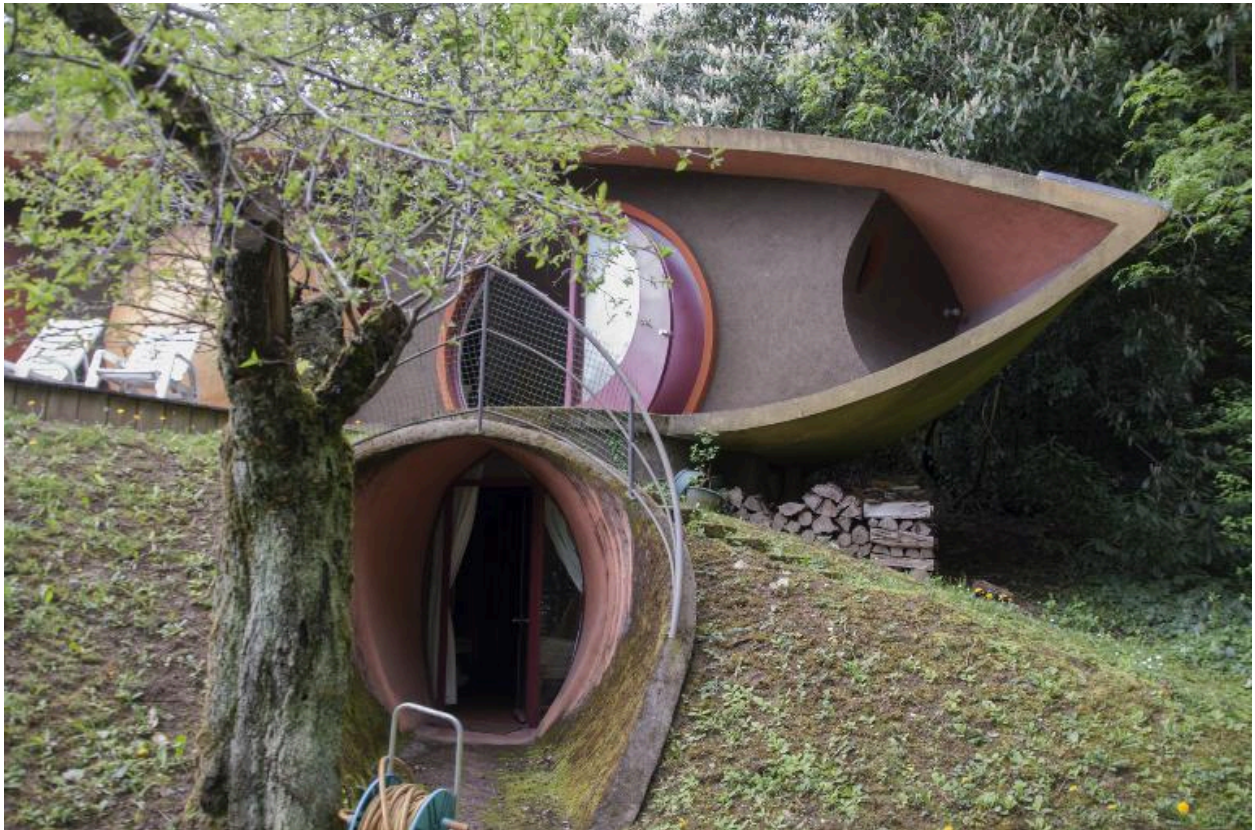
Détail sur l'extrémité sud et l'accès ouvrant sur la chambre du niveau enterré
