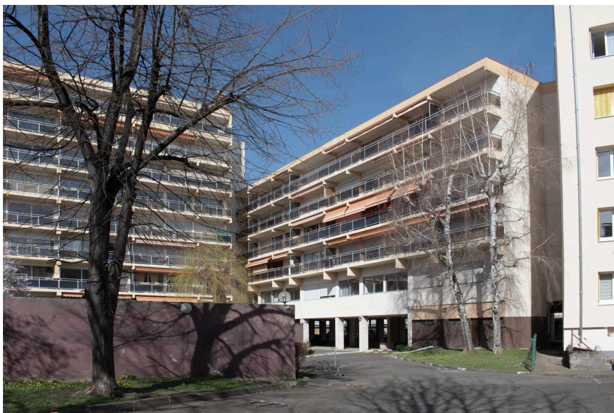
Élévation postérieure et façade sur cour
