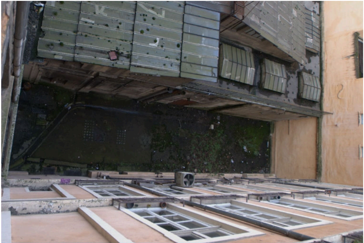
Passage principal, vue zénithale ouest
