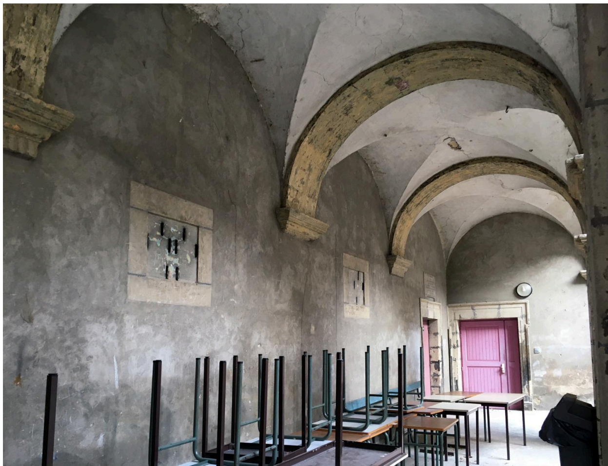
Bâtiment A, cour, galerie nord vue d'ouest en est
