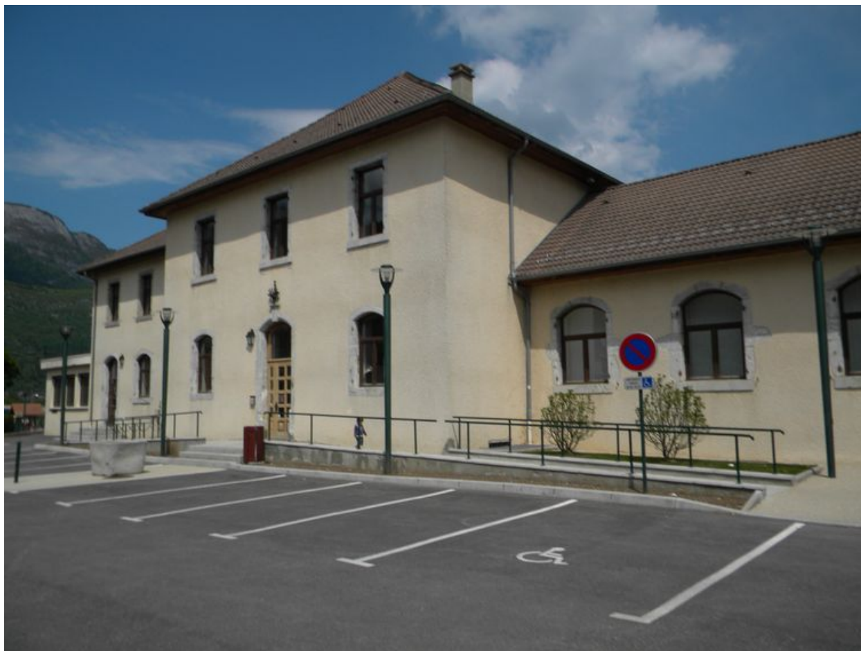
Vue générale de la façade principale.
