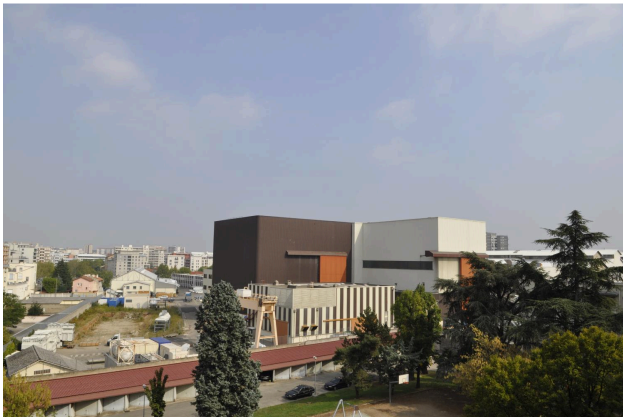
Vue des structures en bardage au nord
