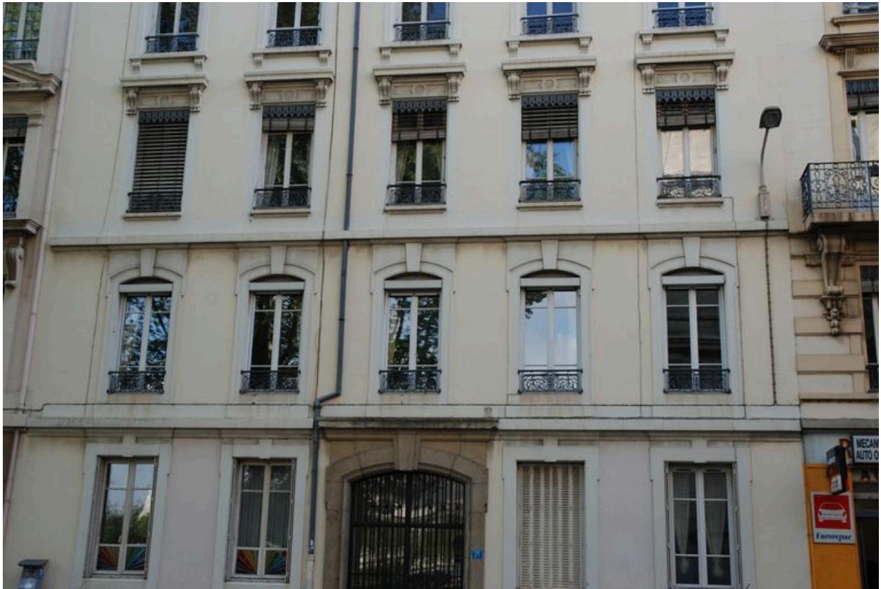
Détail de l'élévation sur rue
