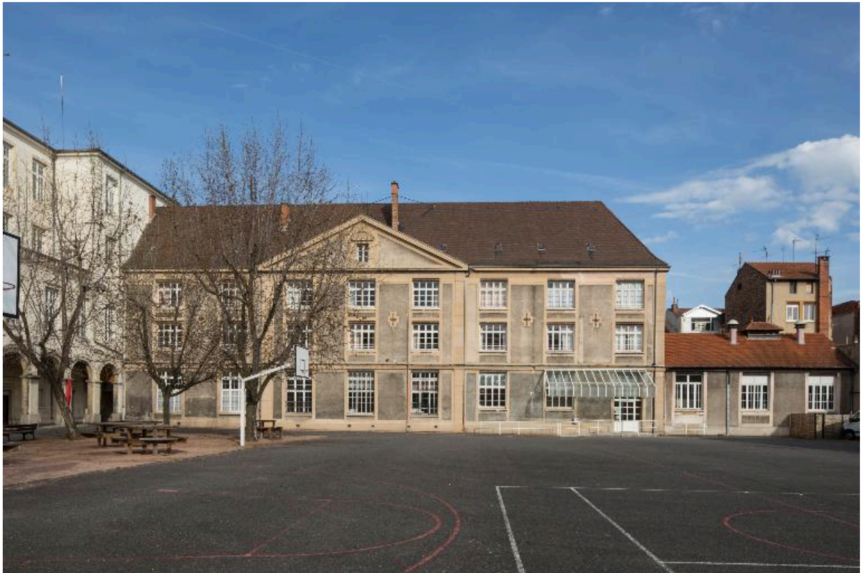
Bâtiment G, 17e siècle, façade orientale
