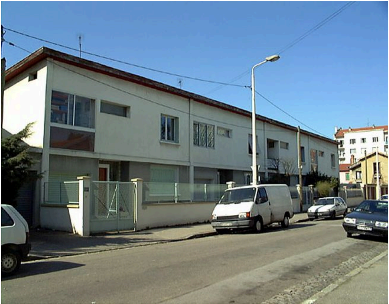
Vue générale des façades sur rue
