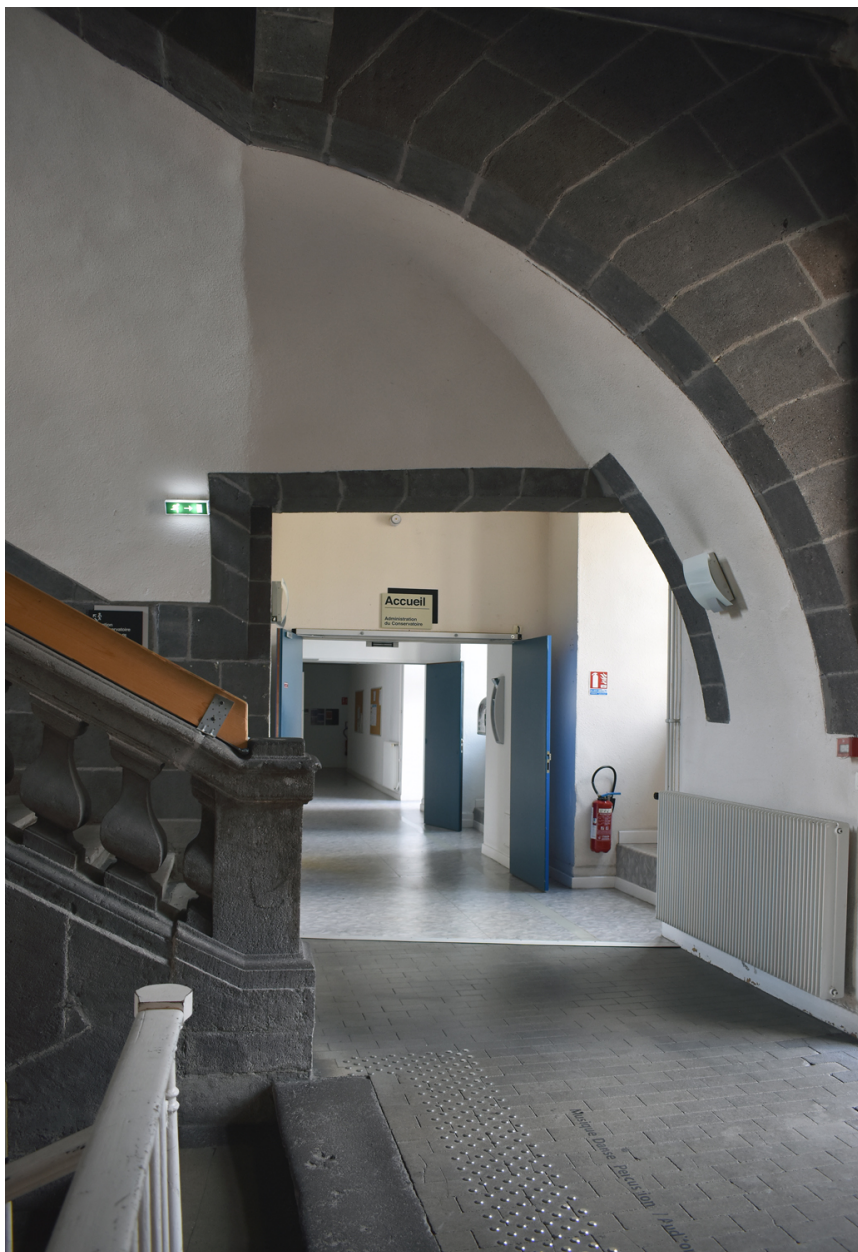
Bâtiment A : couloir du rez-de-chaussée, partie ouest
