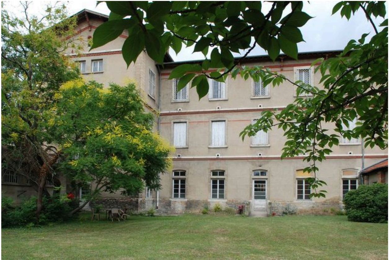
Façade postérieure, partie sud
