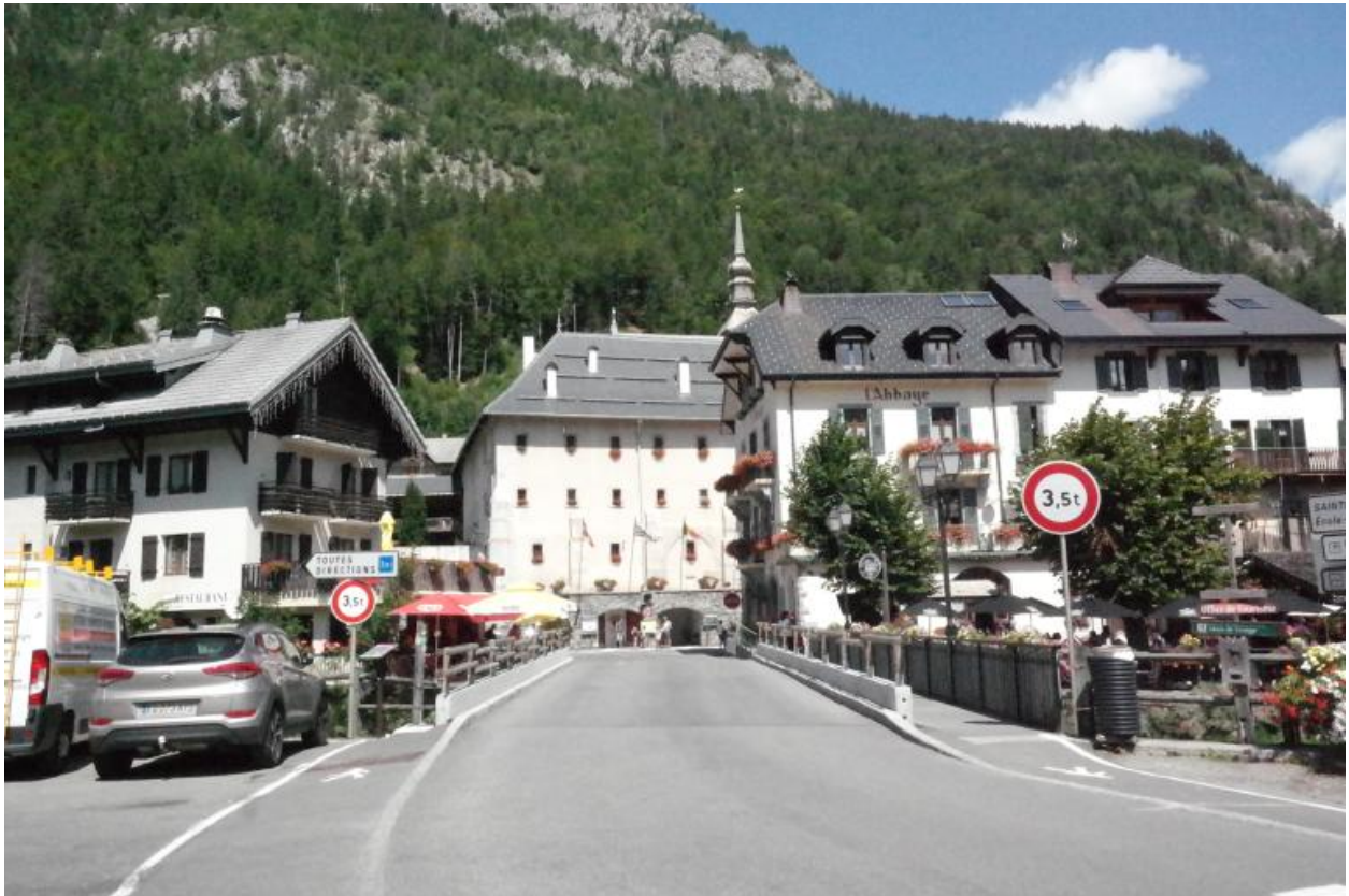
Ancien pont couvert d'Abondance, vue de la chaussée
