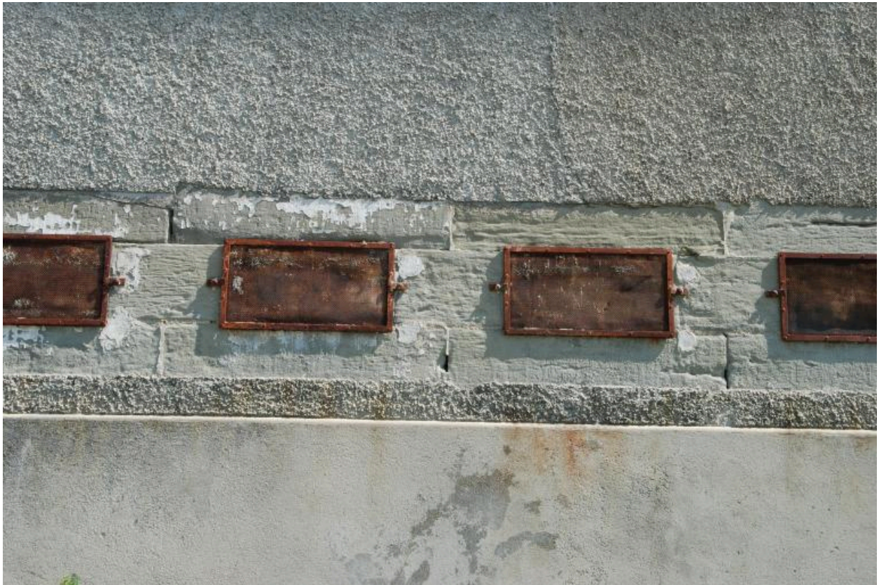
Détail des ouvertures du freidi.
