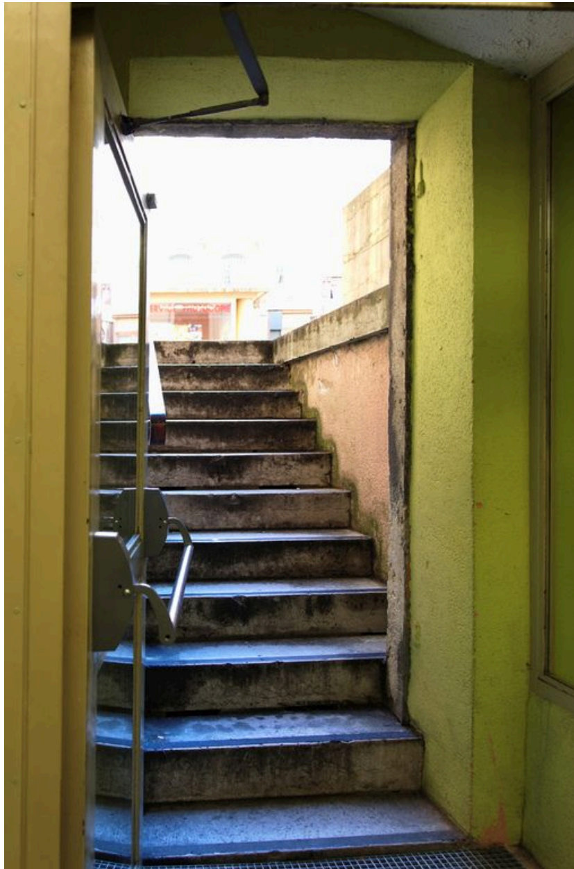
Sous-sol, accès à la cour d'honneur.
