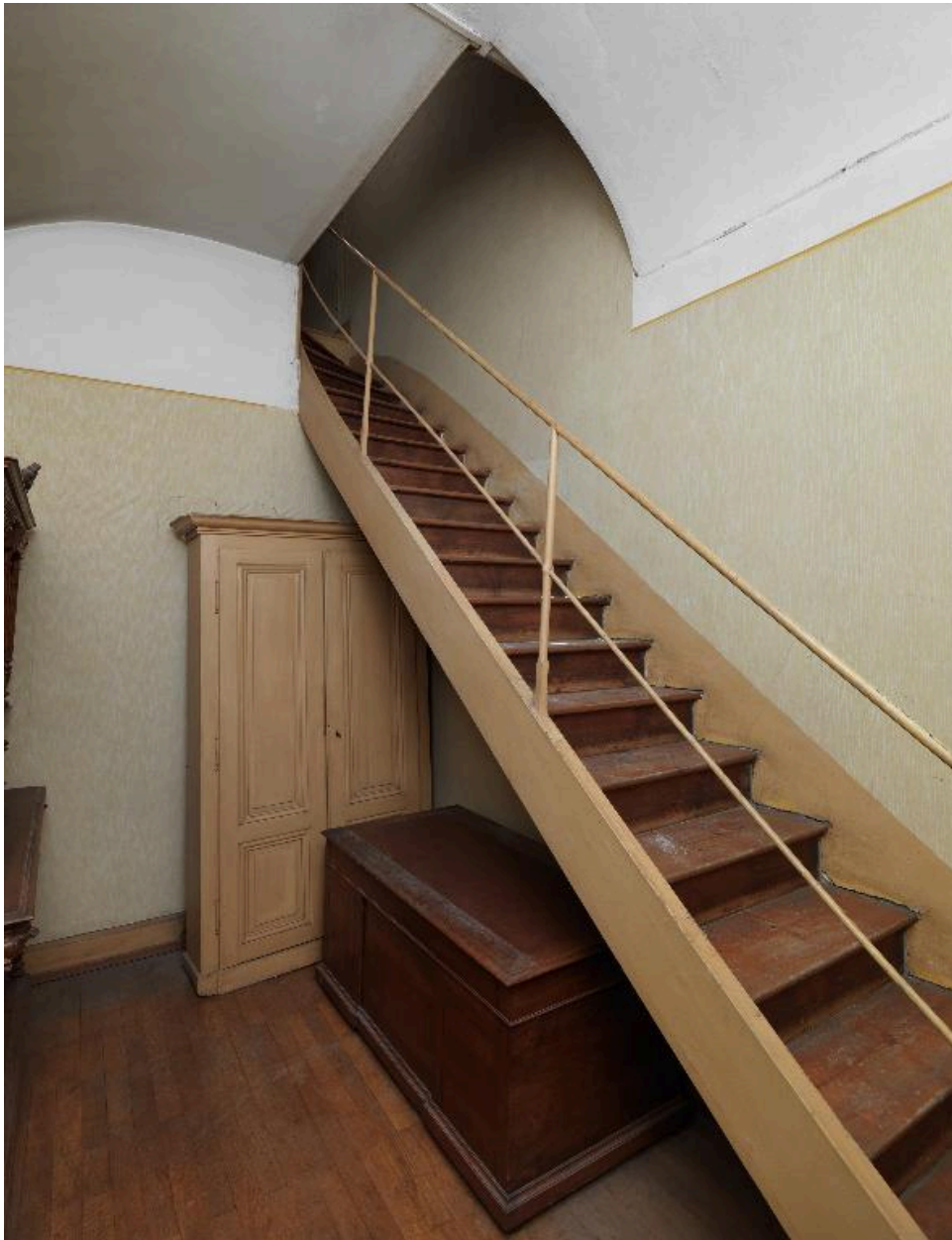
Aile des oratoriens : appartement du 1er étage, 2nd escalier intérieur
