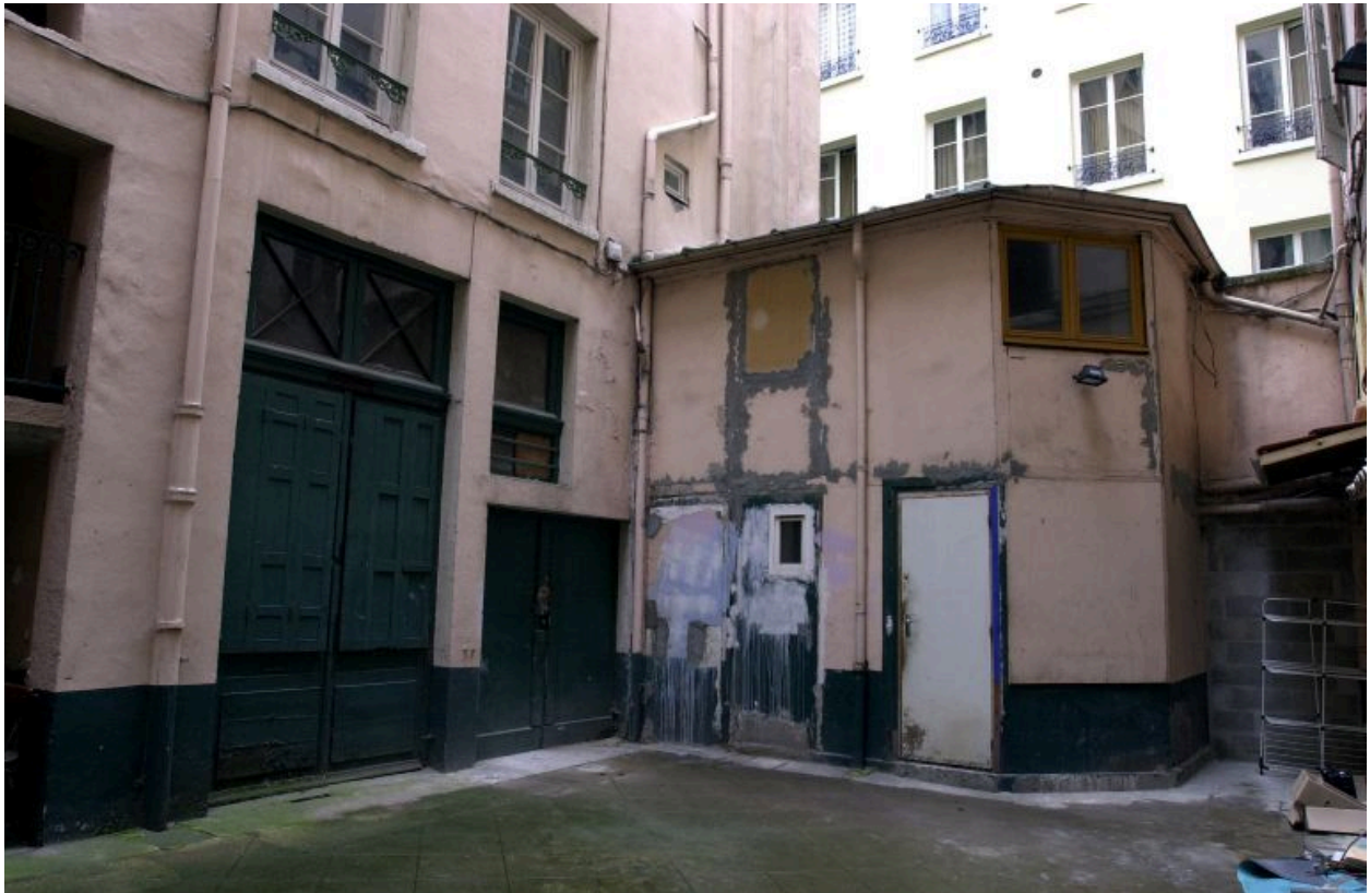
Vue de la loge de concierge dans l'angle sud-ouest de la cour
