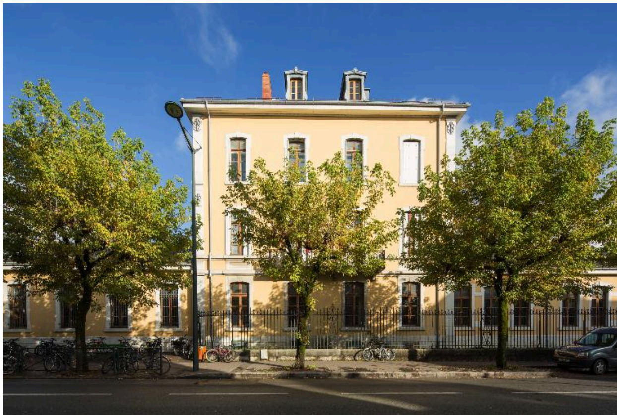
Façade boulevard du Lycée.
