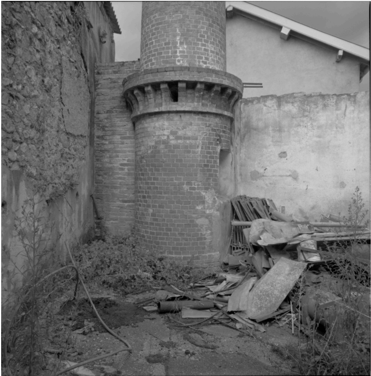
Base de la cheminée attenante au garage et à l'atelier.
