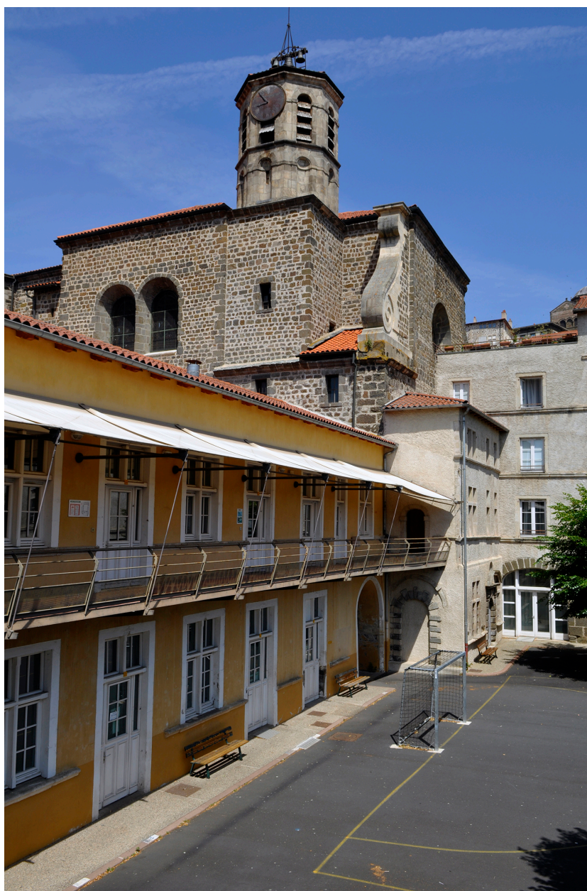
Bâtiment C, élévation sur cour 2 depuis le sud
