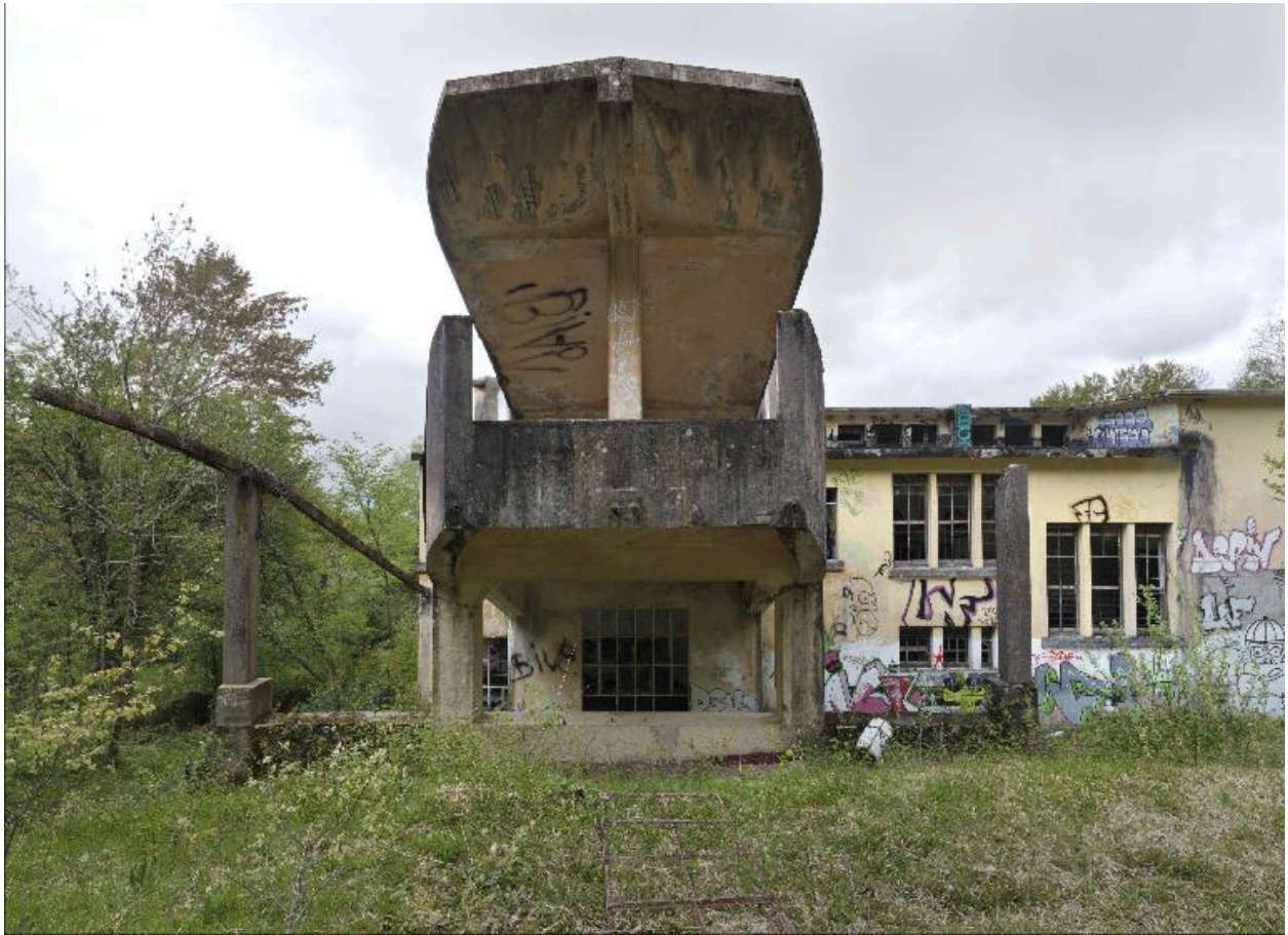
Escalier extérieur d'embarquement
