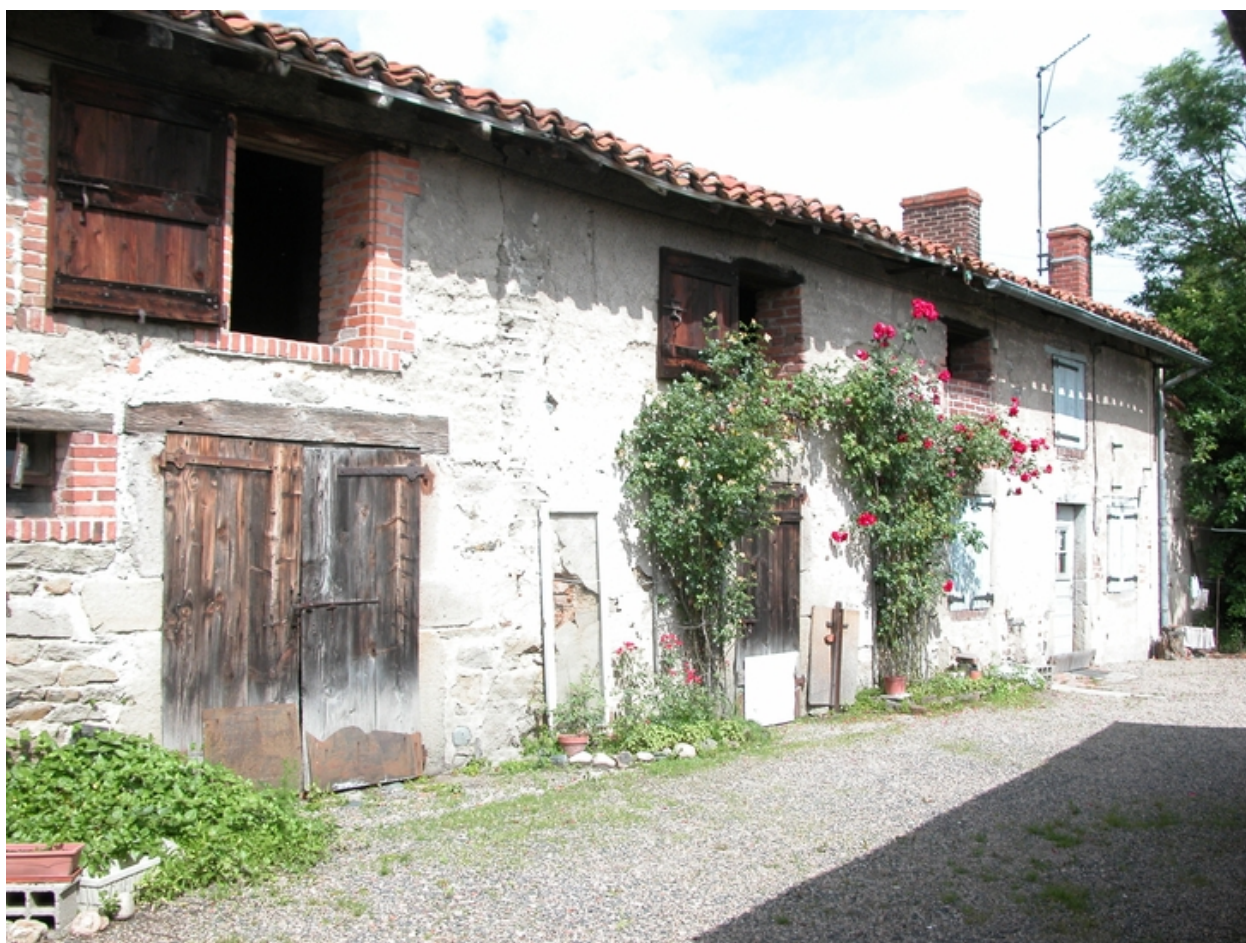
Vue de l'extrémité nord du bâtiment ouest, depuis le sud-ouest.
