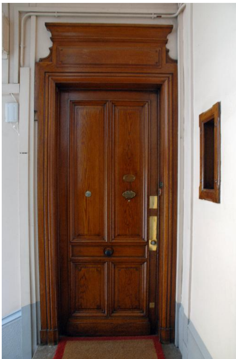
Vue intérieure : une porte palière
