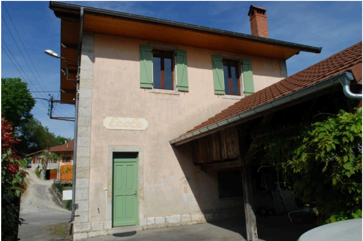
Vue d'ensemble de la façade avant.
