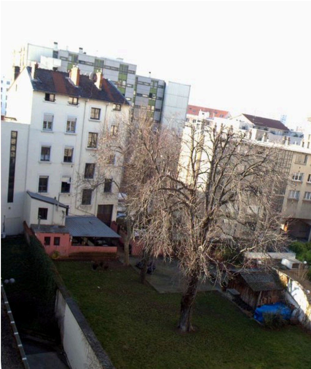
Elévation postérieure et jardin
