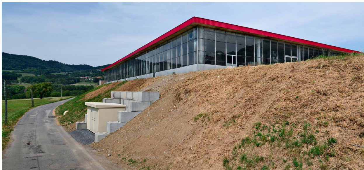
Vue d'ensemble nord de l'usine
