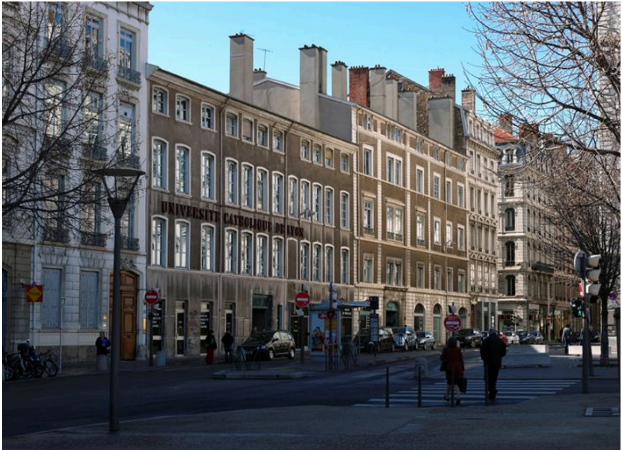
Vue d'ensemble des immeubles 31 place Bellecour et 10-12 rue Antoine de Saint-Exupéry
