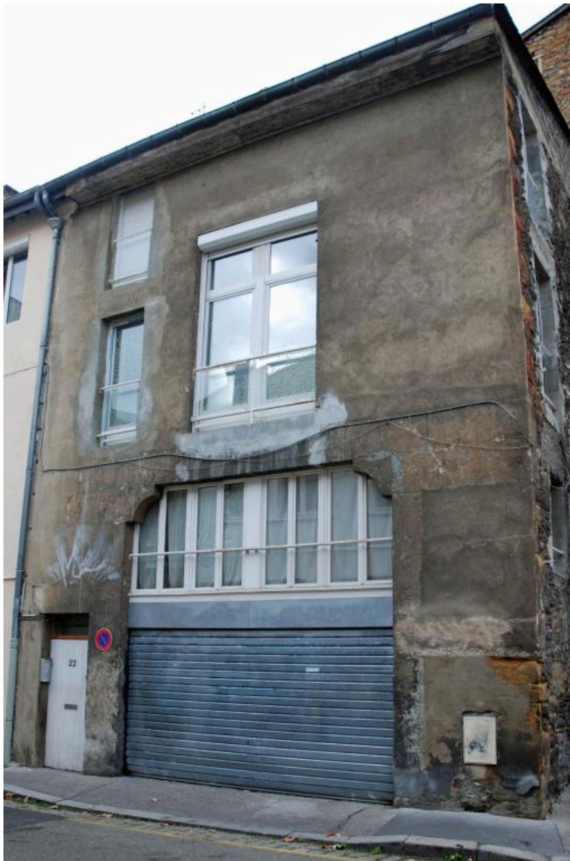
Ancienne remise transformée en logements, élévation sur la rue Mazagran
