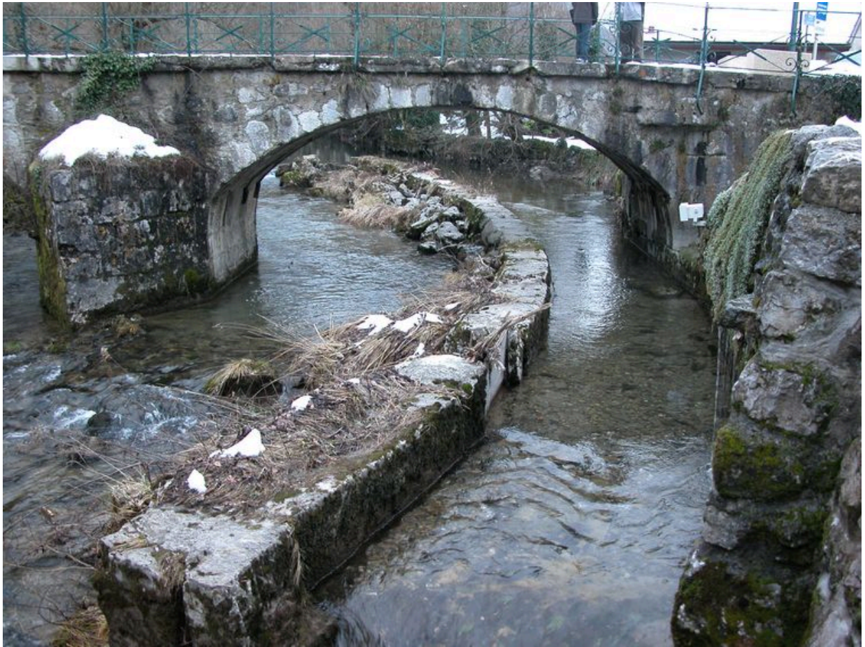
Canal de dérivation sous le pont.
