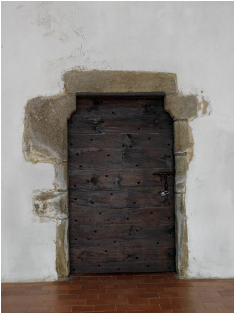
Encadrement de porte du 14e siècle.
