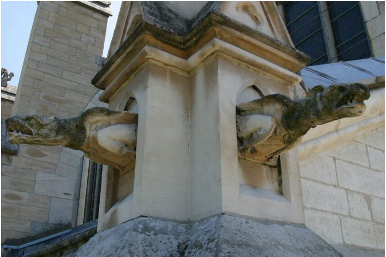
Gargouilles situées à l'angle des élévations nord et ouest : vue d'ensemble
