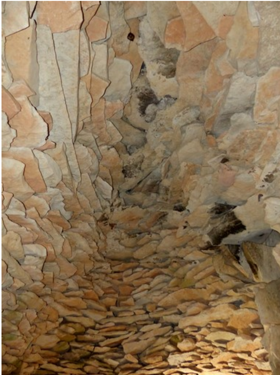
Cabane nord. Coupole en encorbellement.
