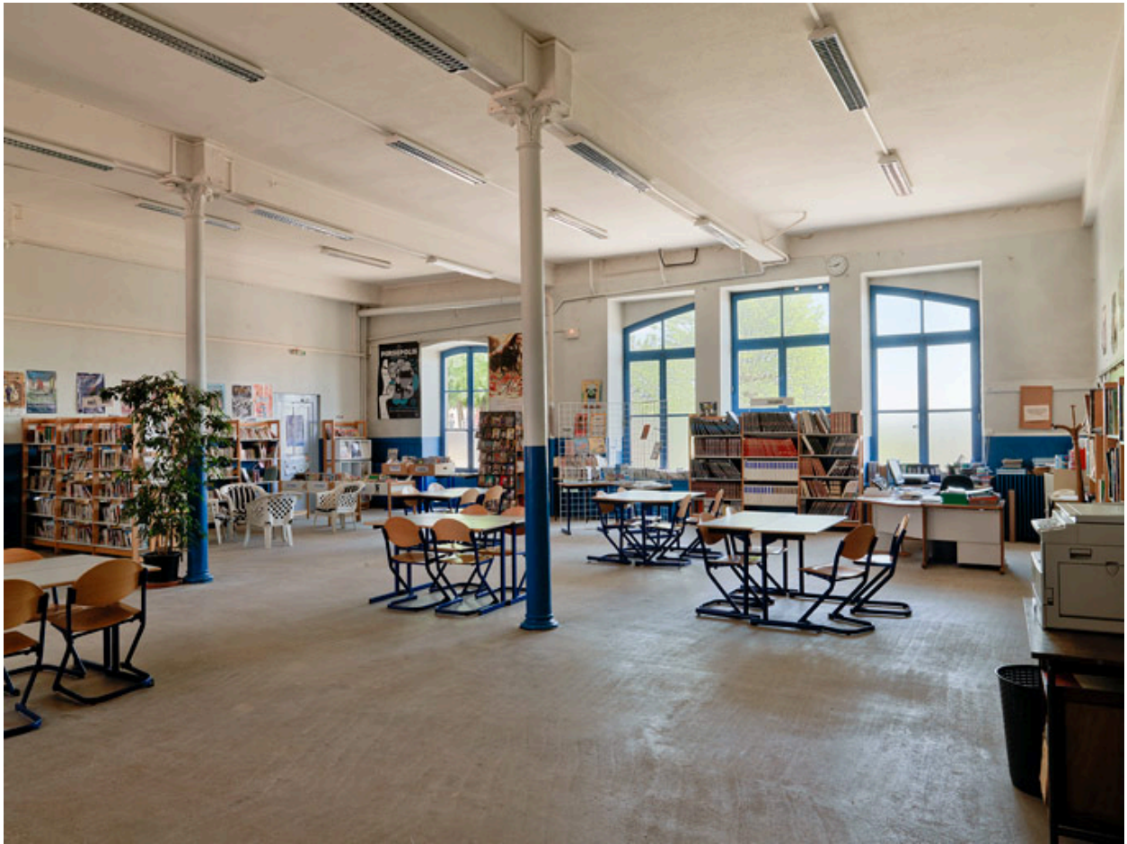
Salle de classe soutenue par des colonnettes en fonte, bâtiment D.
