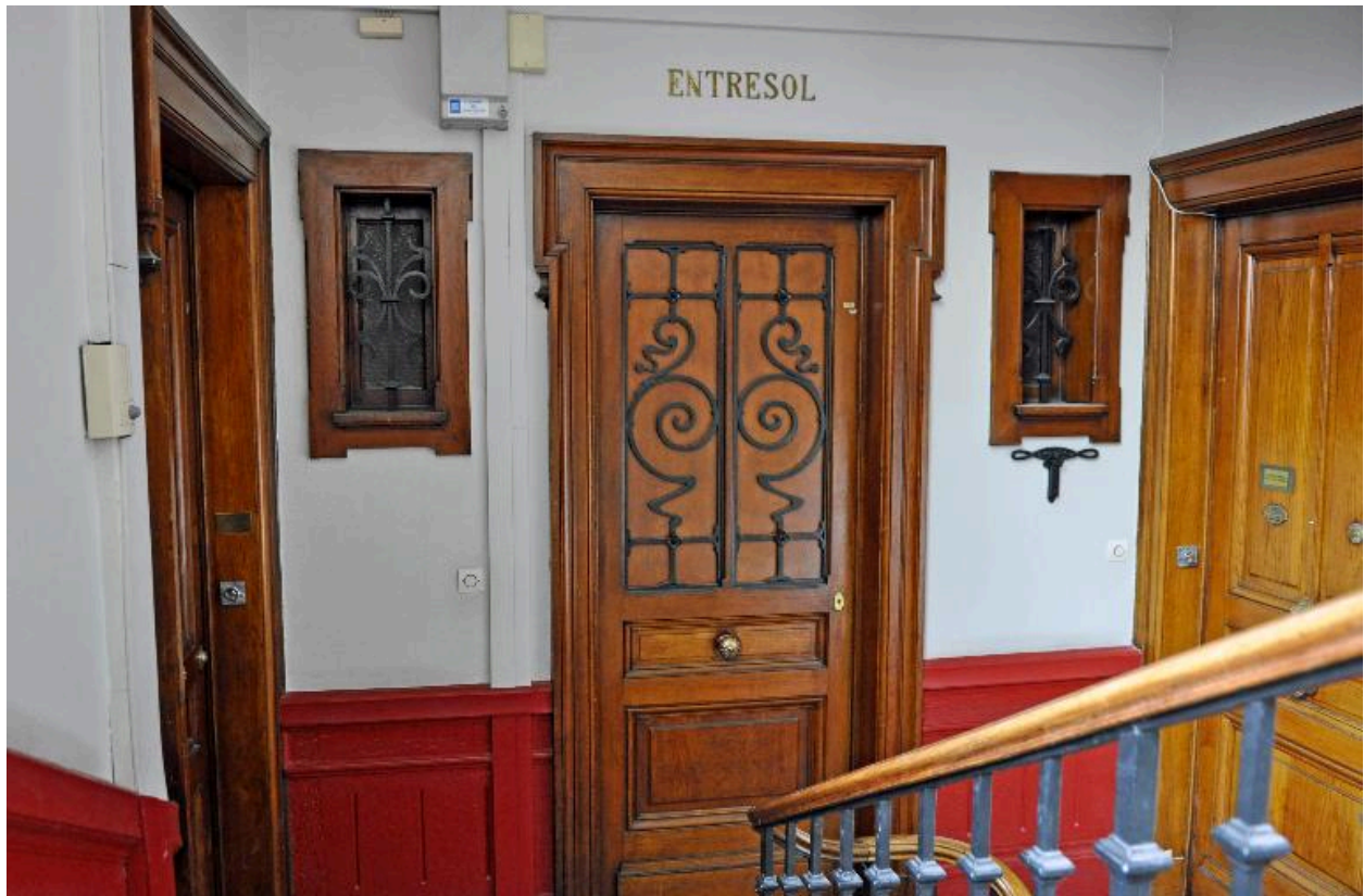
Vue du palier du premier étage, dit entresol
