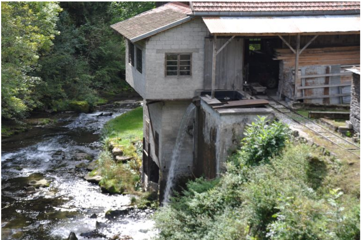
Détail du bassin de retenue et du trop plein
