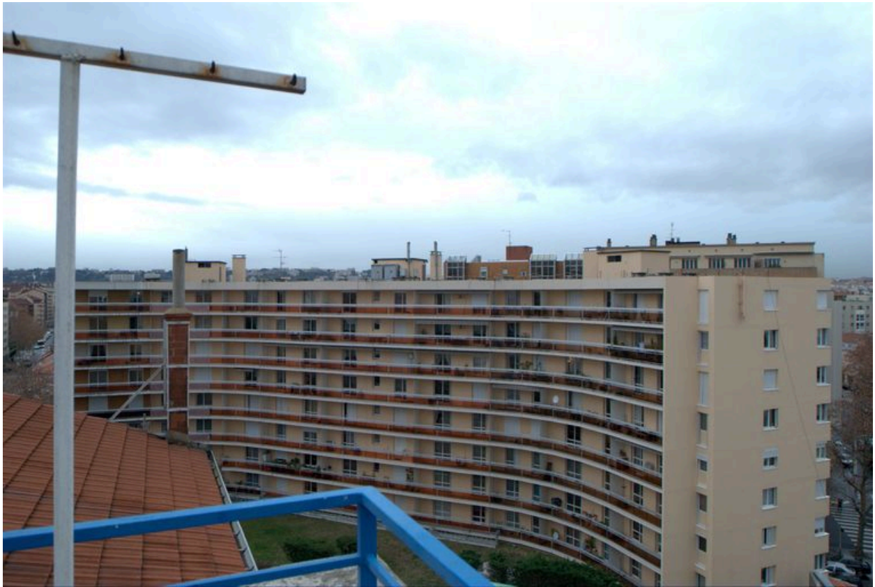
Elévation postérieure depuis la terrasse du 67 rue Domer
