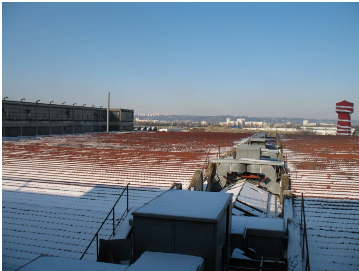
Vue d'ensemble des toits
