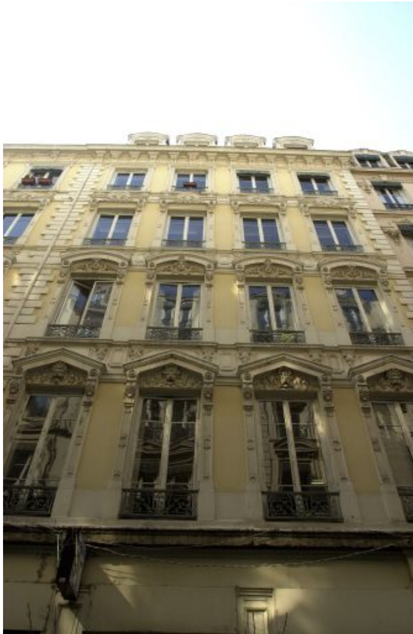
Façade rue Longue, travées latérales droites
