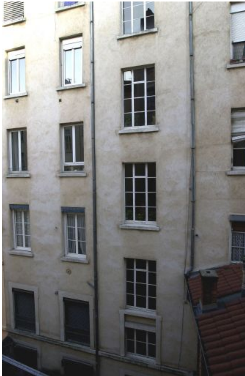
Détail de la travée d'escalier sur cour
