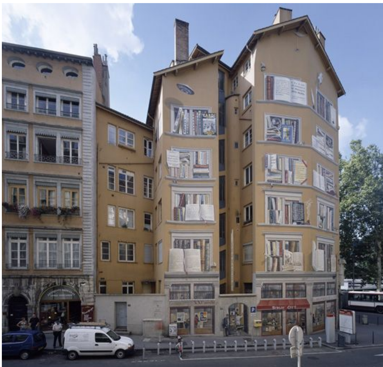
Vue générale des élévations sur la rue de la Platière
