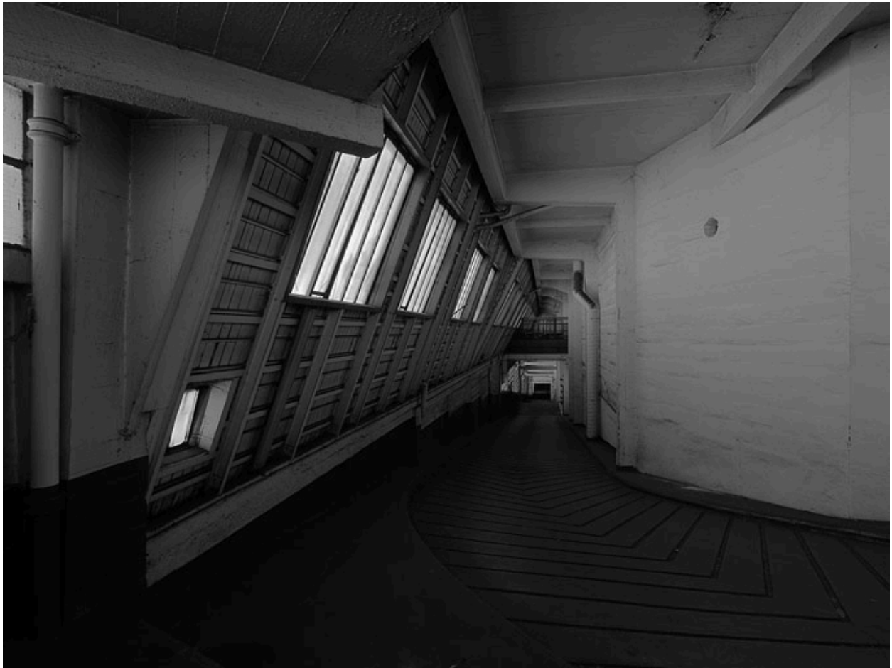
Vue générale rampe montante (avec toit brisé)
