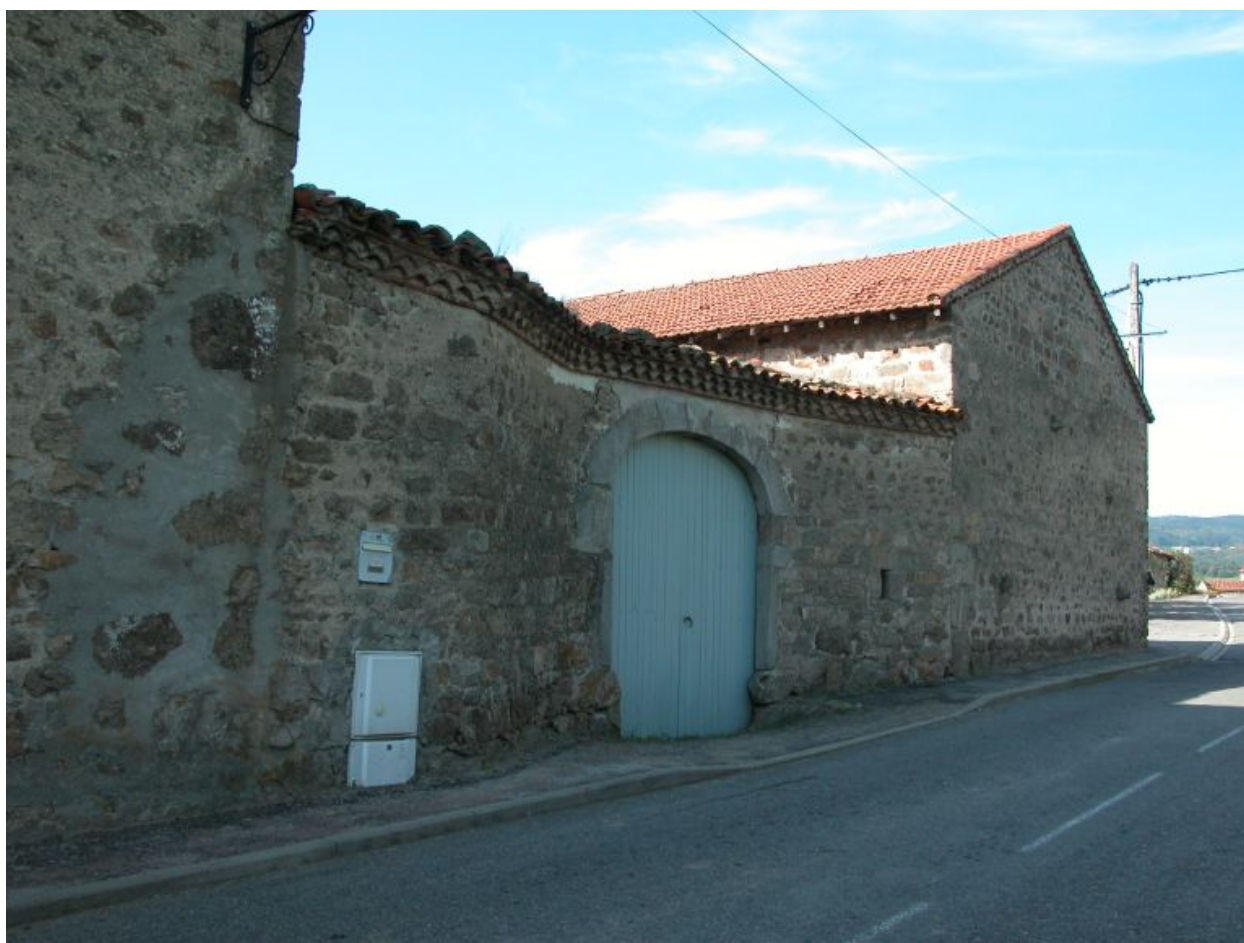
Elévation d'ensemble du portail d'accès à la cour.
