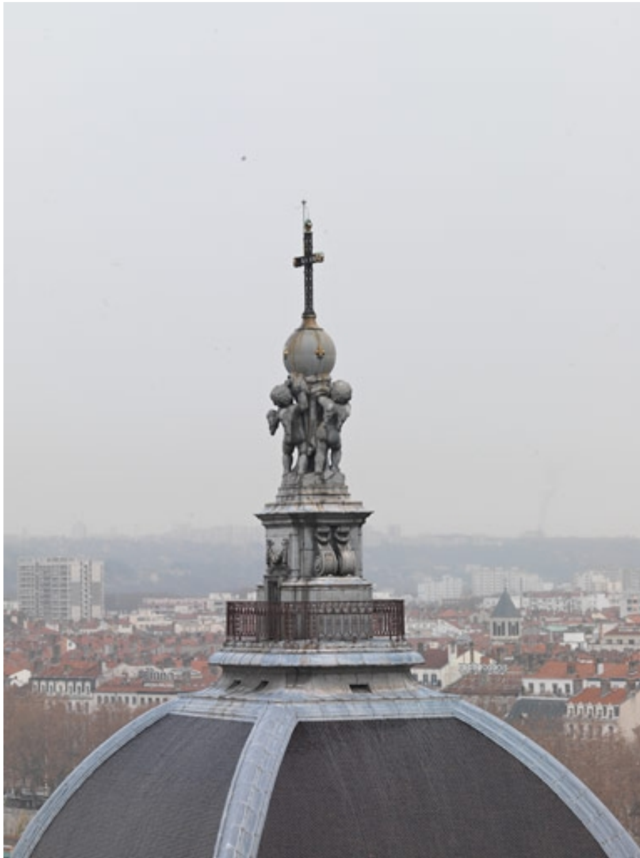
Le dôme Soufflot. Vue d'ensemble du lanternon
