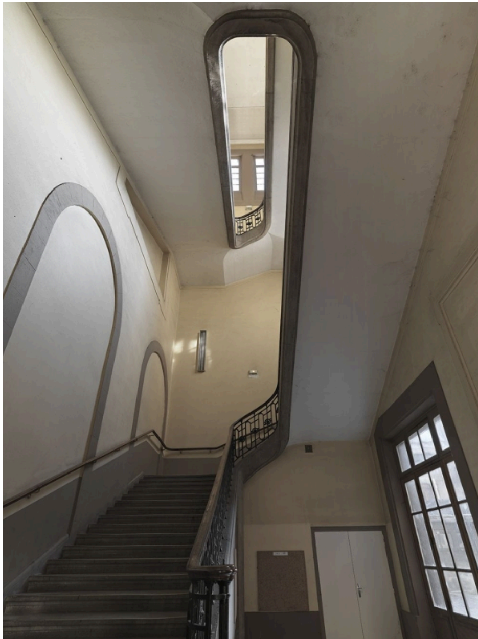
Bâtiment A. Vue d'ensemble de la cage du grand escalier
