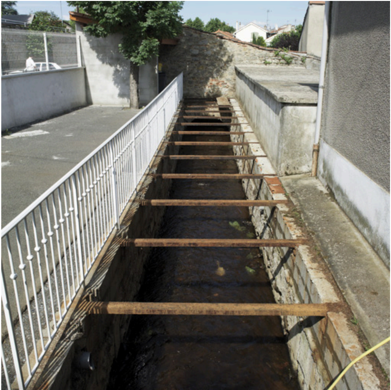
Vue partielle du bief, appelé bief des moulins, traversant la cour.
