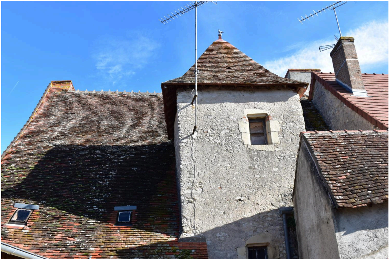
Détail de la tour d'escalier au sud.
