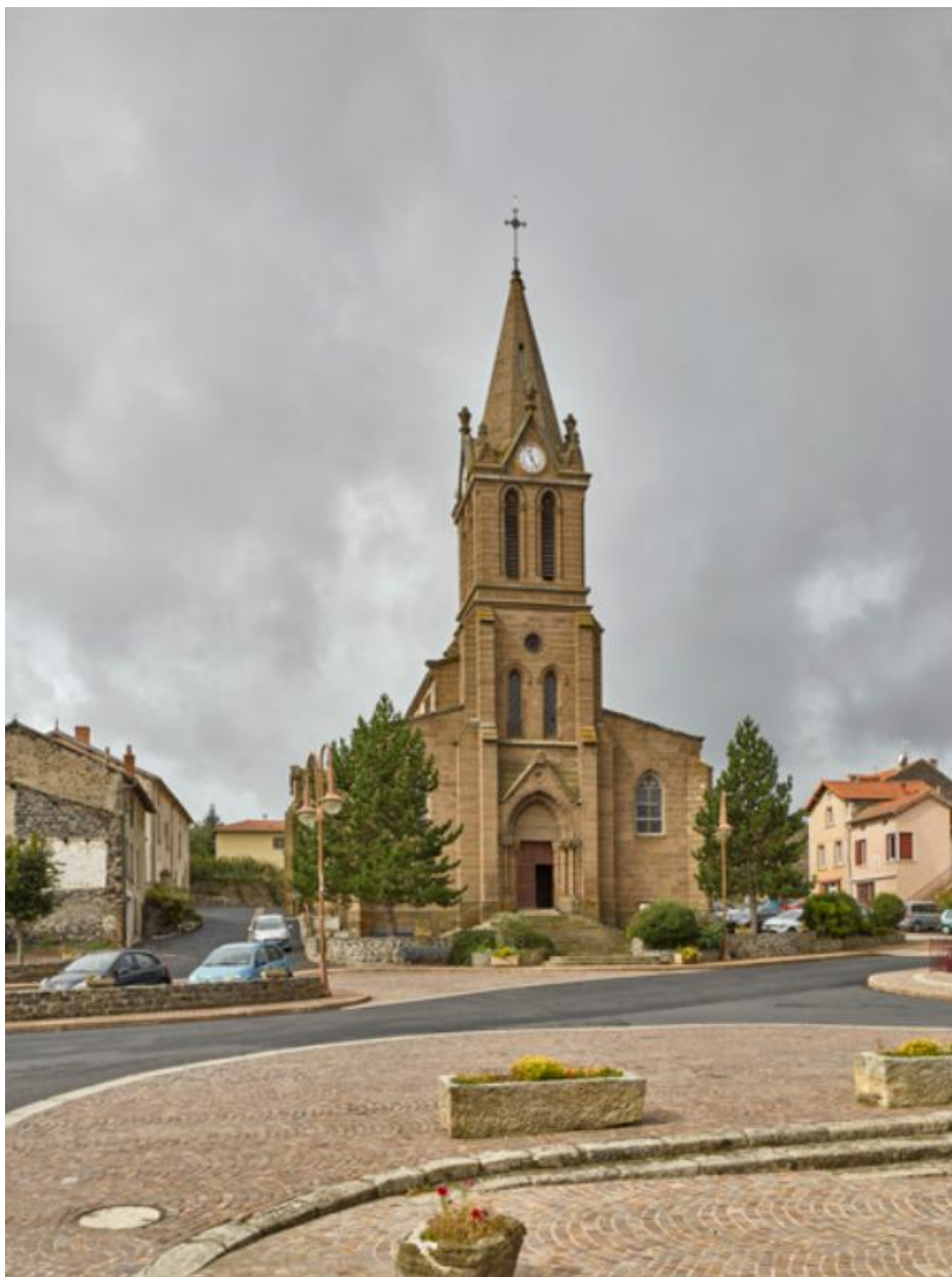
Vue de la façade occidentale
