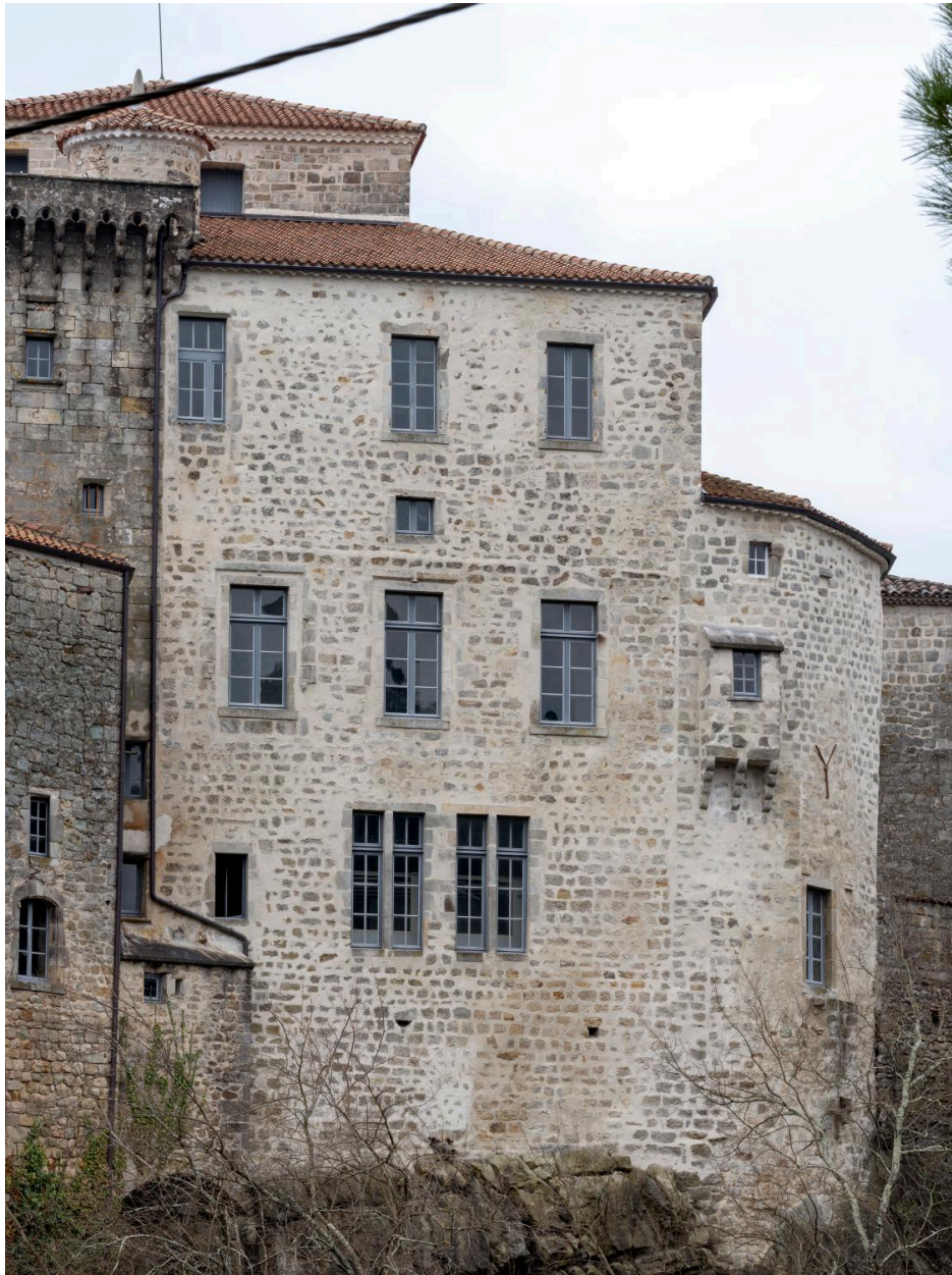
Élévation nord : partie ouest
