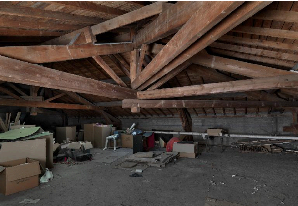
Pavillon sud : comble avec charpente bois
